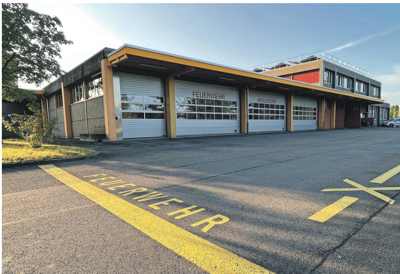
Das Feuerwehrmagazin an der Industriestrasse soll saniert und erweitert werden. Foto pd
